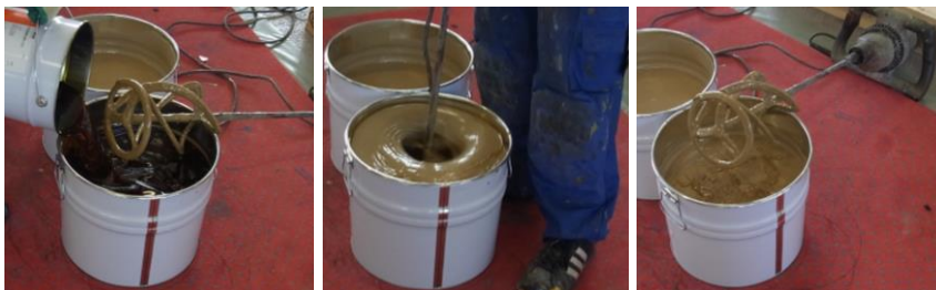
Anrühren des 2-Komponenten PU-Klebers
